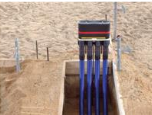
Beispiel für den Einbau einer Mehrspartenhauseinführung
