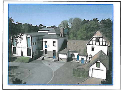
Wasserwerk der Stadtwerke Bramsche GmbH
